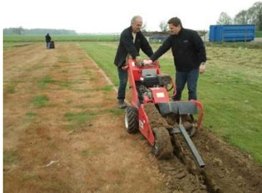
La trancheuse renvoie la terre sur un des cotés par une vis sans fin et avance à la vitesse de 100 mètres à l'heure environ (bien choisir le ses d'avancement en fonction du coté de dépôt de la terre)
